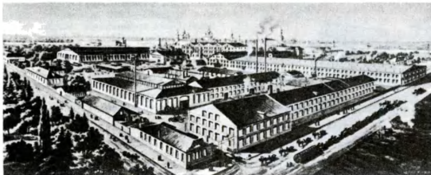
Механический завод братьев Бромлей в Москве. Общий вид. 1899.
